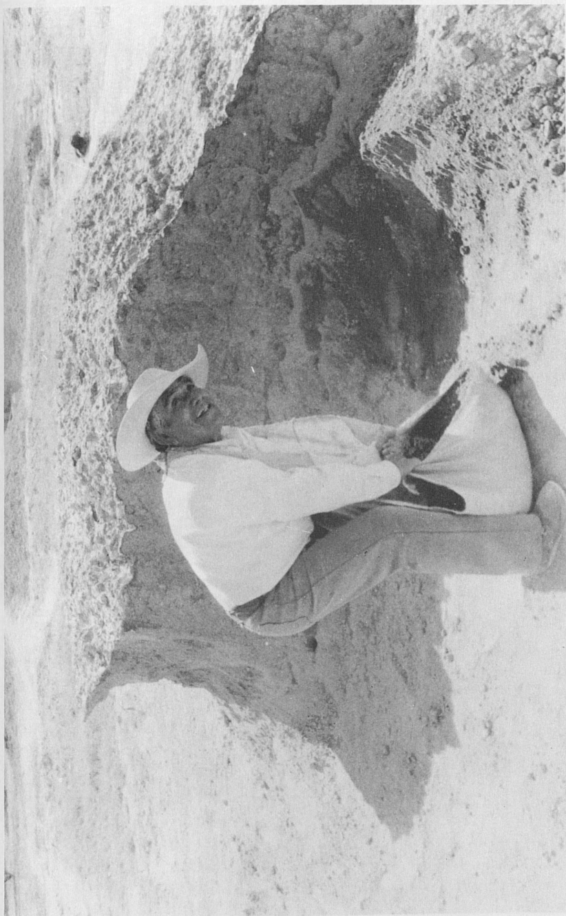
Figura 8. El guangoche es una especie de costal que se utilizaba para transportar la tierra hasta la estiladera, antes de ser reemplazado por la carretilla.
