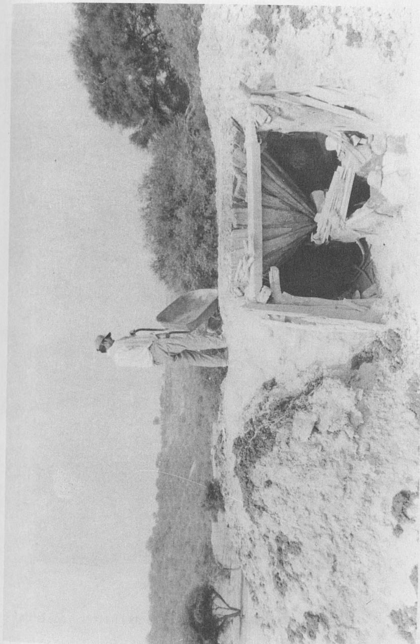
Figura 12. La tierra se echa dentro de la estiladera utilizando una carretilla. Nótese la acumulación de tierra desechada alrededor de la estiladera, formando el "terrero".
