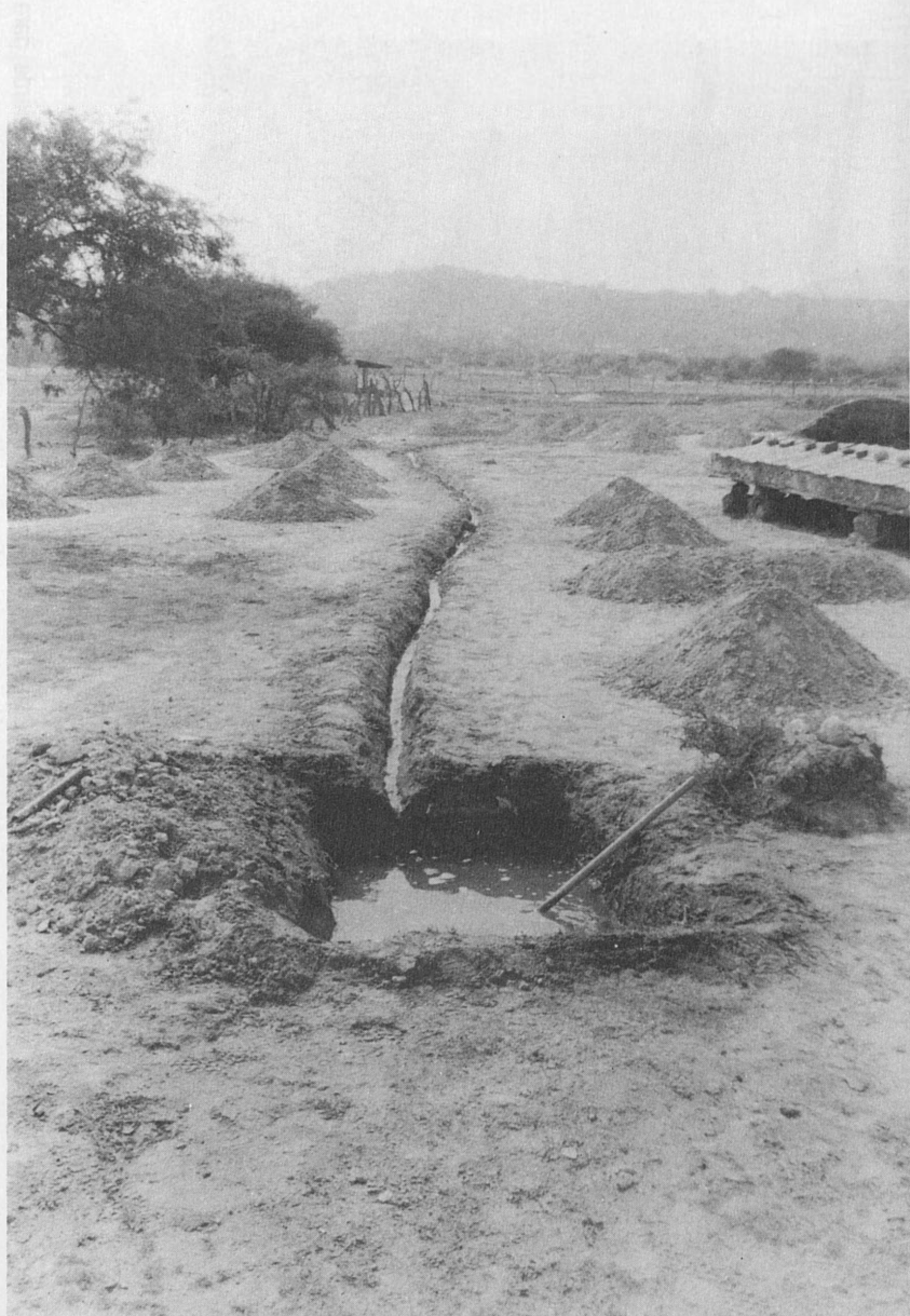
Figura 7. Cada finca cuenta con al menos un pozo como éste, del cual se conduce el agua por medio de canales hasta las estiladeras.
