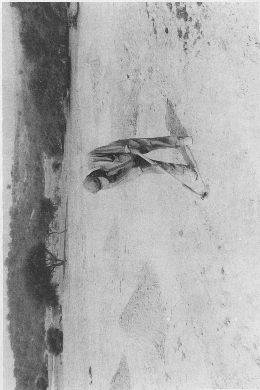
Figura 11. De esta manera se excava la "tierra picada" dentro de la finca, para luego apliarse en pequeños montículos.
