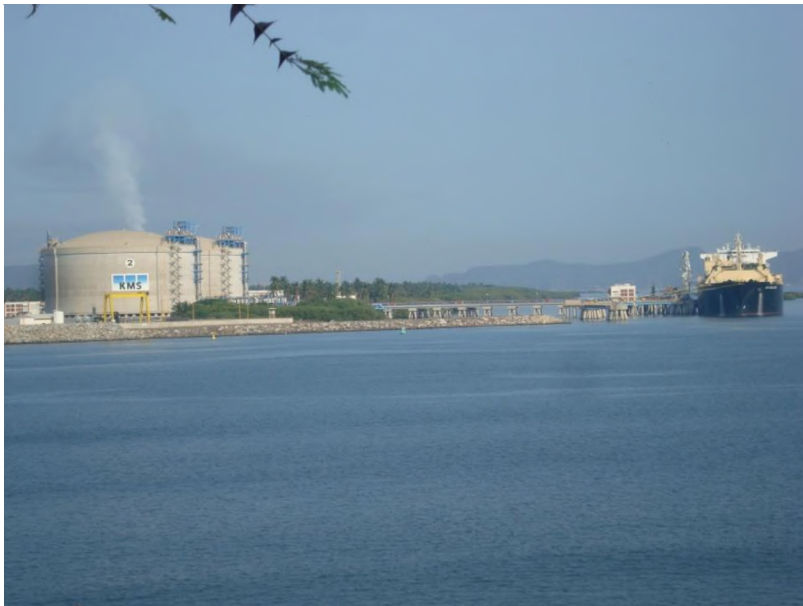
Imagen 7. Barco metanero atracado al interior del Vaso II de la Laguna de Cuytlán, mientras descarga gas LP hacia la planta regasificadora.
