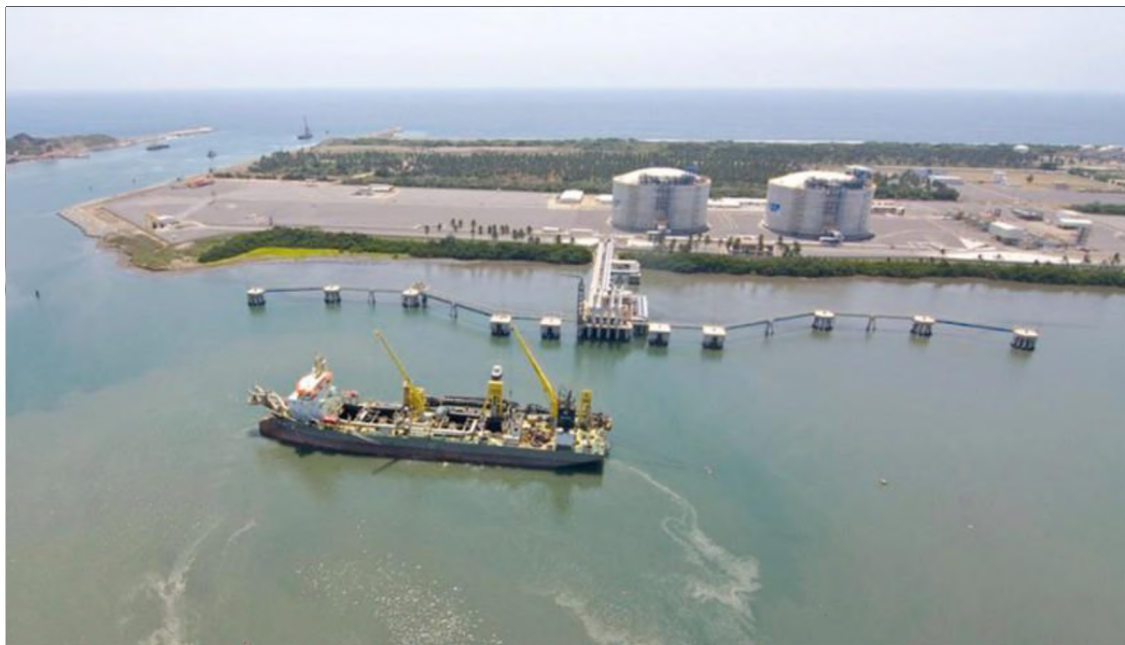
Imagen 3. Planta de Tratamiento de Gas Natural Licuado (regasificadora)
