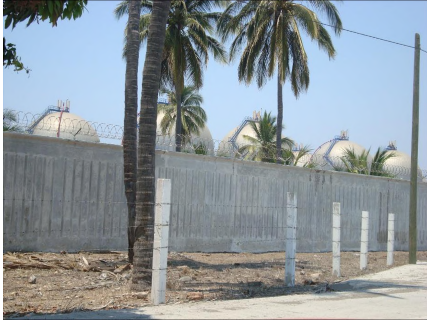
Imagen 2. Tanques de almacenamiento de gas licuado de petróleo (LP). Fuente: Archivo fotográfico propio. Abril del 2013.
