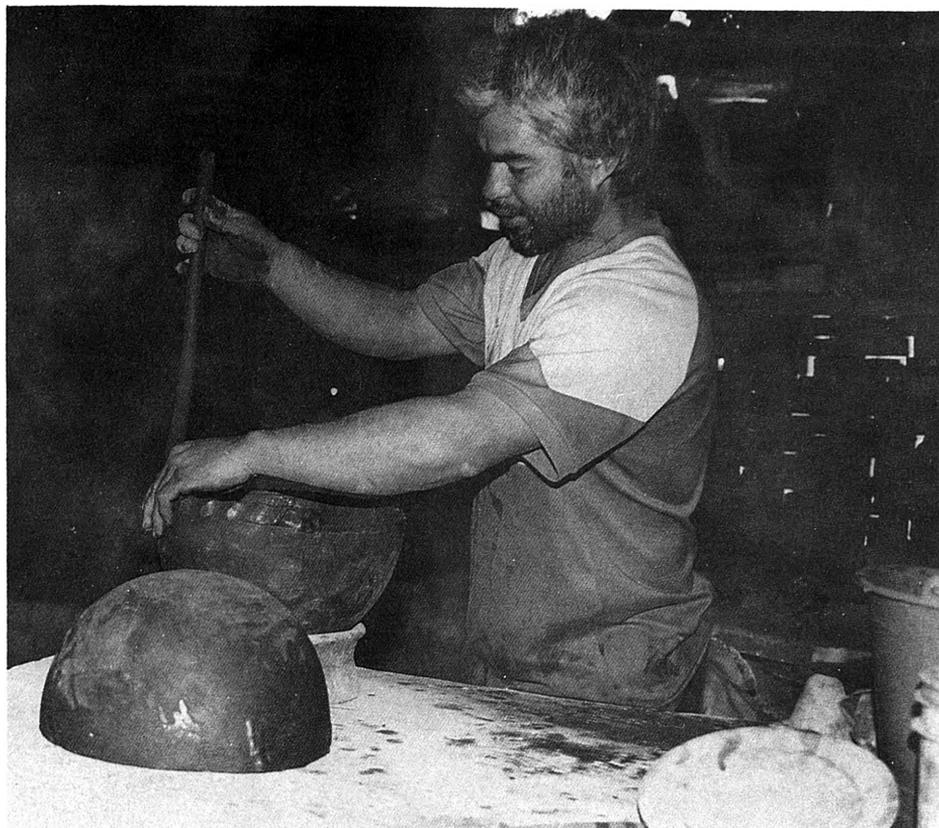
Fig. 8. Manufactura de una "chonda" en Zinapécuaro, Michoacán. El alfarero utiliza el método de "enrollado" para formar la vasija.
