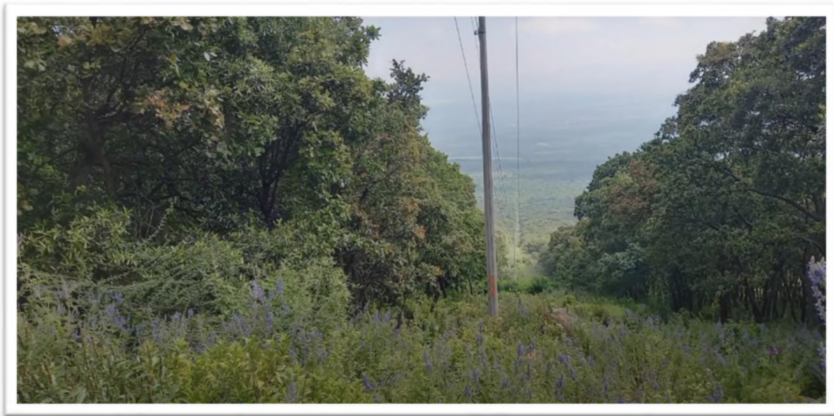
Figura 45. Franja de servidumbre de la línea eléctrica de la CFE que atraviesa el Cerro Grande. A pesar de la perturbación, esta zona ha experimentado un proceso de regeneración natural, en el que destaca la presencia y crecimiento de poblaciones de Agastache , es especialmente en los claros abiertos que permiten mayor entrada de luz. Archivo personal, septiembre 2024.
