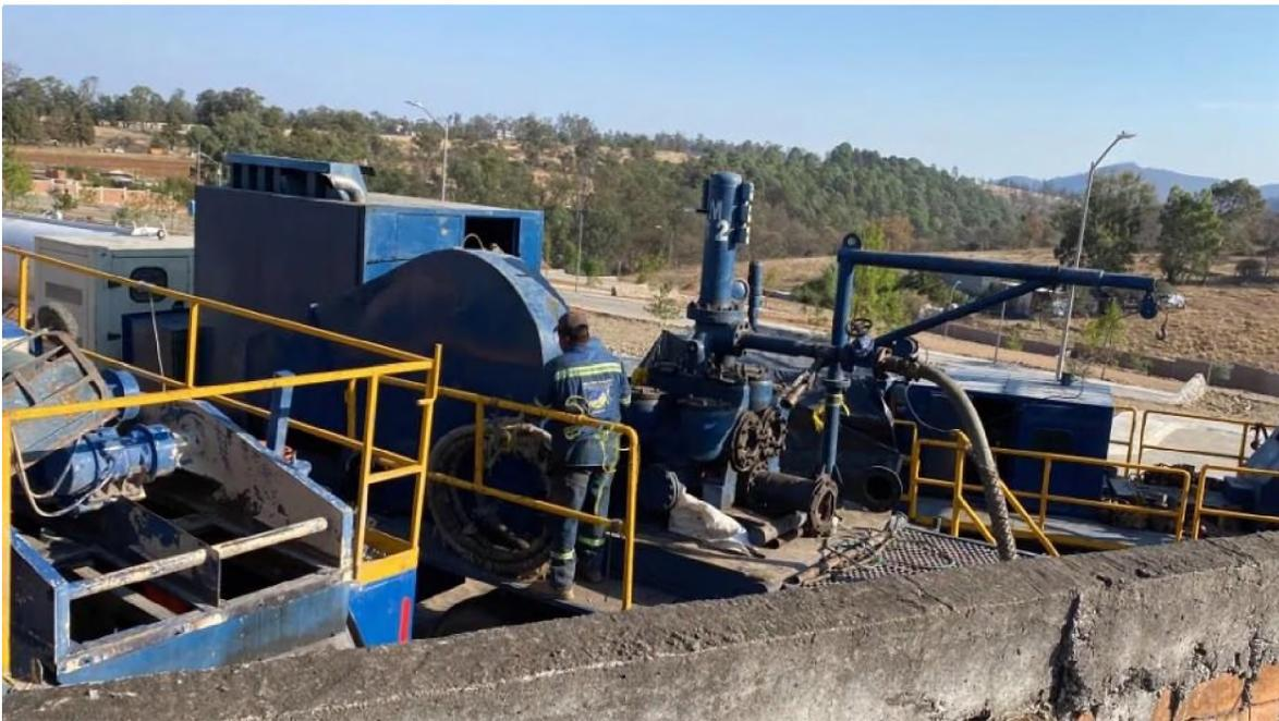
Imagen 44. Maquinaria que se utilizó para poder construir el pozo de agua en el fraccionamiento privado de Casar. La ubicación de dicho pozo se encuentra a 10 metros del manantial El Tejocote. Archivo de Gil (2023).
