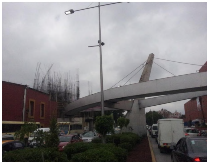
Dstrucción de casona en el Barrio del Artista para construcción del teleférico, Boulevard 5 de mayo
