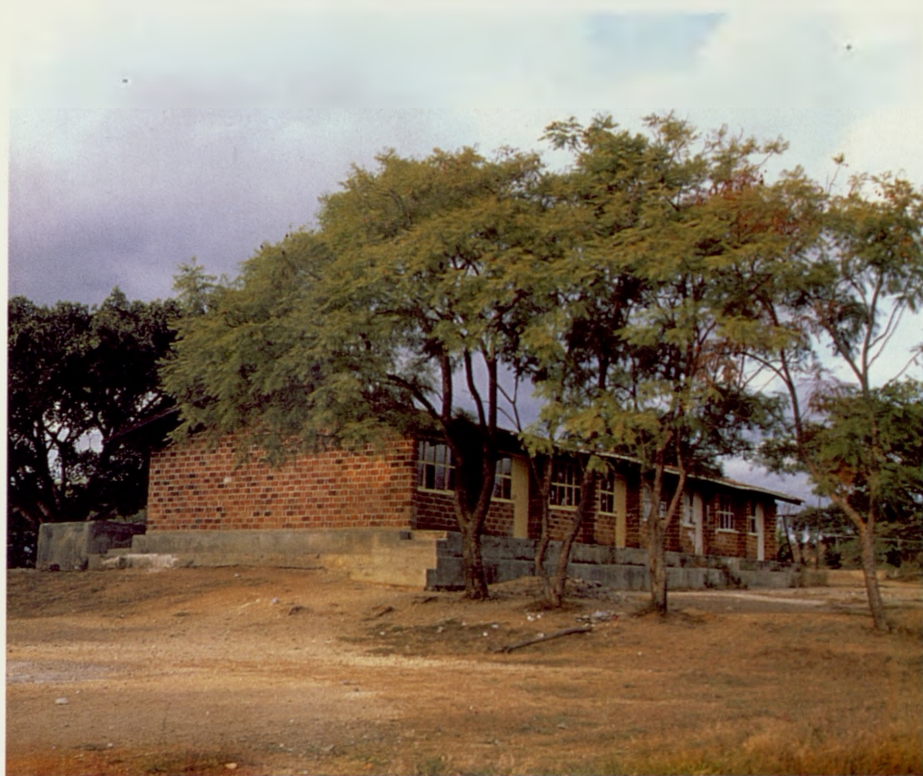
Escuela primaria federal que se construyó en La Aurora gracias al Plan del Sur de Jalisco.
