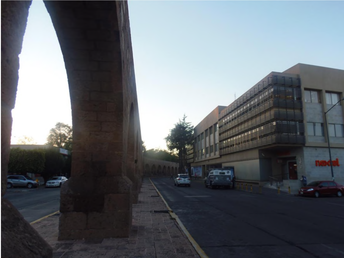
Imagen 17. Edificio de la empresa DECOMICH S.A. de C.V., que rebasa la altura del acueducto y rompe con la arquitectura del centro histórico. Archivo propio de octubre de 2014.
