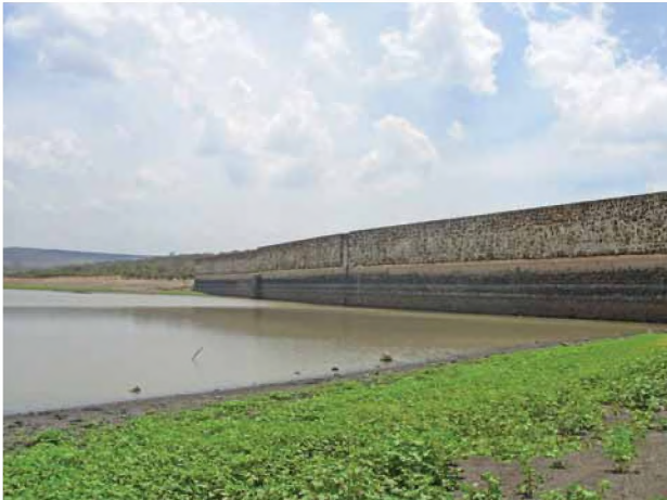
Figura 6. Vaso y vista interior de la cortina de la represa vieja de Jalpa. Fotografía del autor, junio 2011.
